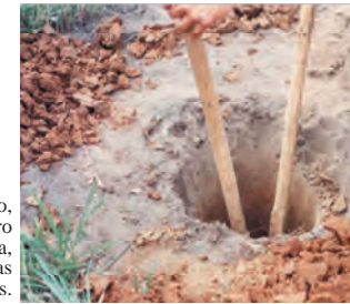
Rodovia Carvalho Pinto, Lote 1 - Área limpa para controle de ocorrências arqueológicas superficiais.
